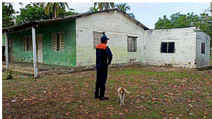
Imagen No. 4. Vista frontal de vivienda en concreto en el predio del sector de Arroyo de las Canoas.
