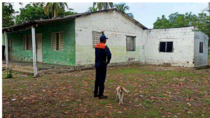
Imagen No. 4. Vista frontal de vivienda en concreto en el predio del sector de Arroyo de las Canoas.
