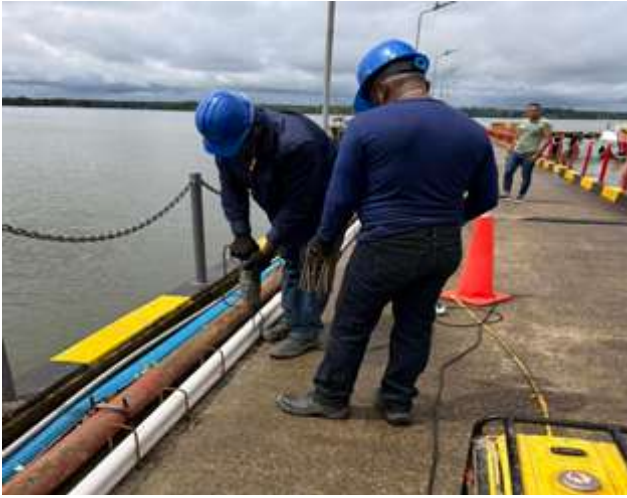
Figura 20. Mantenimiento mayor muelle Buenaventura
