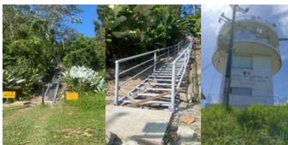
Figura 18. Mantenimiento mayor ECTVM Tumaco
