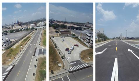
La construcción de la infraestructura urbanística del Complejo Base Naval ARC "Atlántico" consistió en llevar a cabo las obras de las vías, sistema hidráulico, sistema de red contra incendios, sistema de seguridad y control, sistema eléctrico; todo esto de acuerdo a los diseños estructurales obtenidos en la etapa anterior y a las especificaciones técnicas establecidas por la Dimar.
